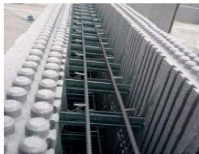
Per le murature perimetrali; VERA INNOVAZIONE della tipologia costruttiva da noi adottata; è l'utilizzo del cassero modulare pre isolato in EPS. Si tratta del così detto sistema SEMI - PREFABBRICATO , in quanto i singoli moduli vengono assemblati in loco. Qui poi, avviene l'integrazione della struttura con l'inserimento di barre acciaio e a completamento avverrà il getto in calcestruzzo utilizzando il medesimo delle sottostanti strutture primarie.
